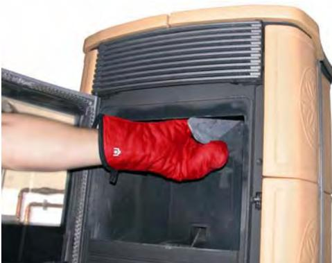
**Kontrollieren Sie insbesondere den sachgerechten Einbau der beiden Ablenkvorrichtungen.**
