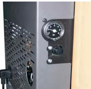
Wichtig vor allem für den Service-Techniker. Befindet sich rückseitig auf der linken Seite des Heizofens und zeigt den Wasserdruck in der Anlage an. Der Druck sollte bei in Betrieb befindlichem Heizofen stets zwischen 1 und 1,5 bar liegen.
