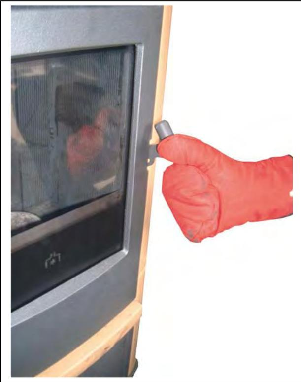
Bei noch abgeschaltetem und kaltem Ofen die Ofentür öffnen.
